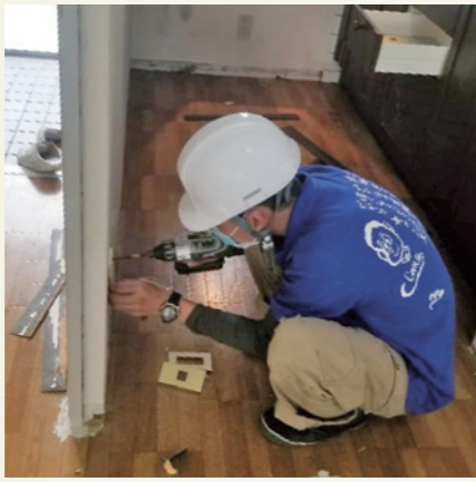
アパートのリフォーム作業(実習時)
