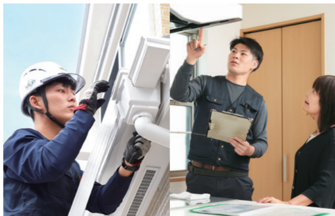
住宅点検の様子
