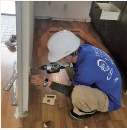
アパートのリフォーム作業(実習時)
